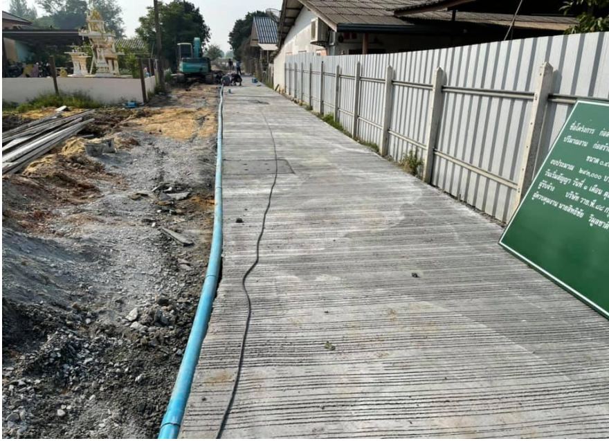
๓.โครงการก่อสร้างถนน คสล.พร้อมวางท่อระบายน้ำ หมู่ที่ ๖ ตำบลวังเย็น
